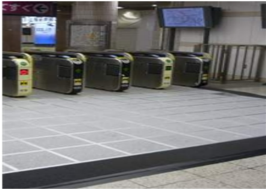
写真 5 実証試験 3 試験状況(改札)
